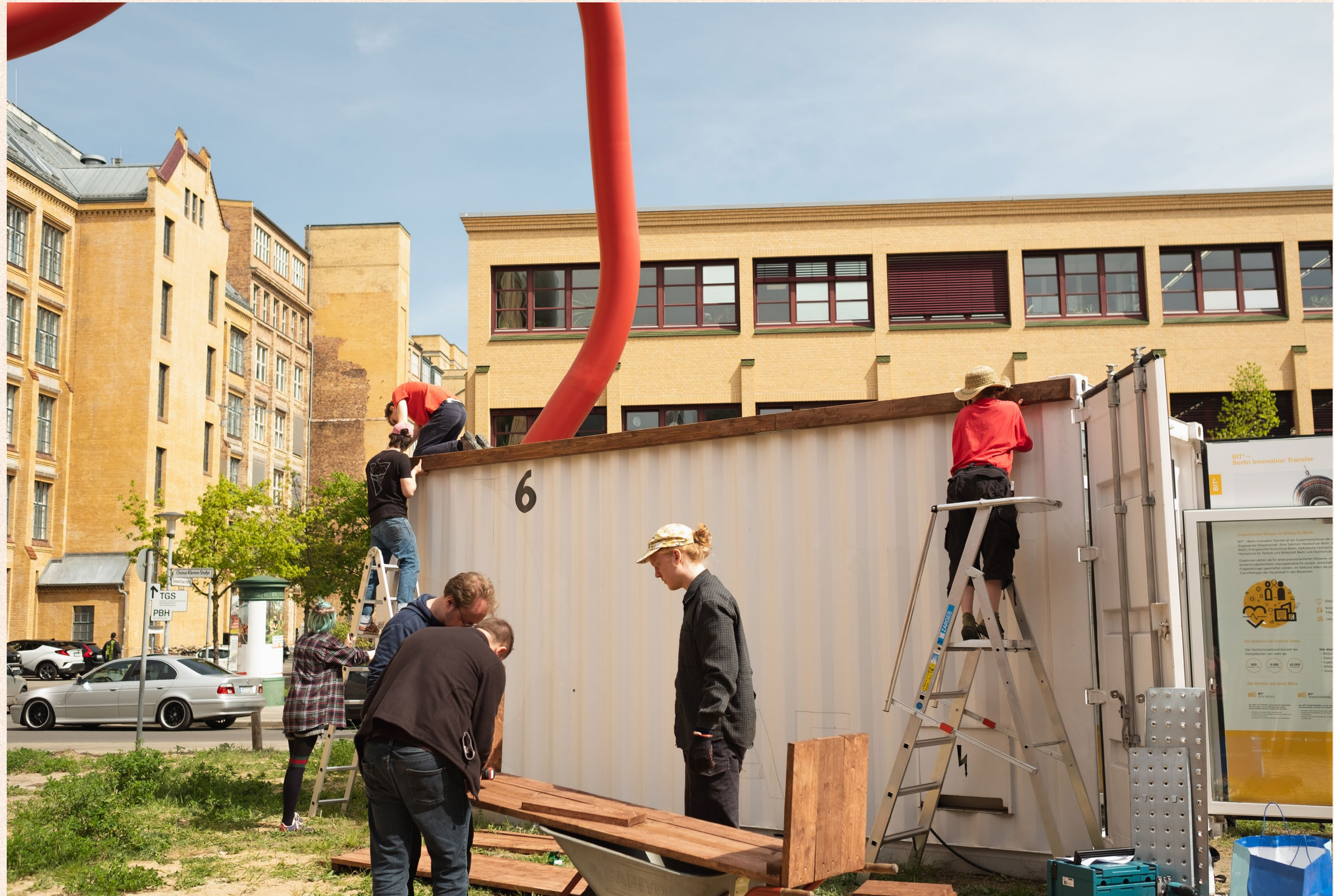
Der tragende Balken wurde an den Container angebracht. Ohne den läuft nichts; Foto: Amina Taouil
