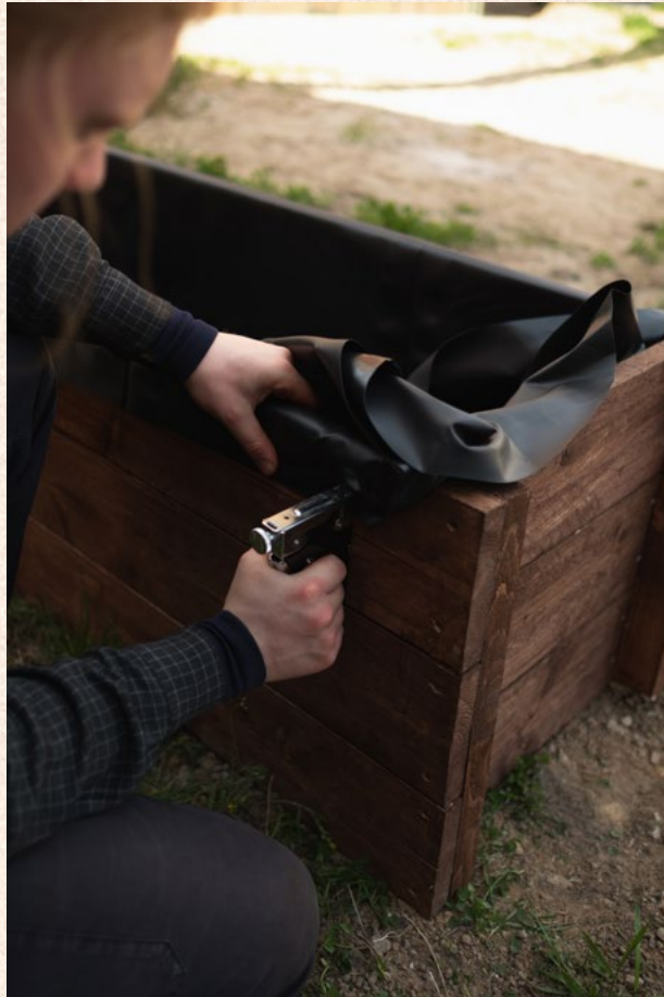
Teichfolie zum Schutz der Pflanzen vor der kontaminierten Berliner Erde; Foto: Simon Herdegen
